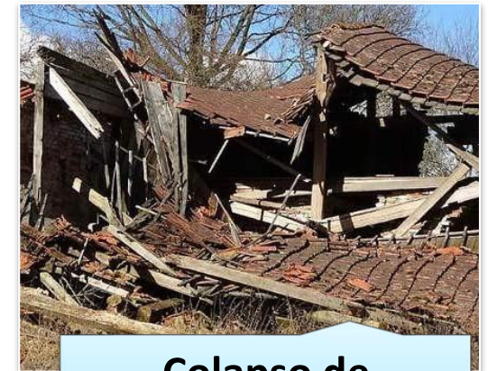
Colapso de estructuras
